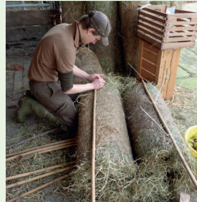
Aan de onderzijde van de hooigaasrollen bevestigen we een bamboestok, voor extra stevigheid en een goede bevestiging aan de gehele constructie
